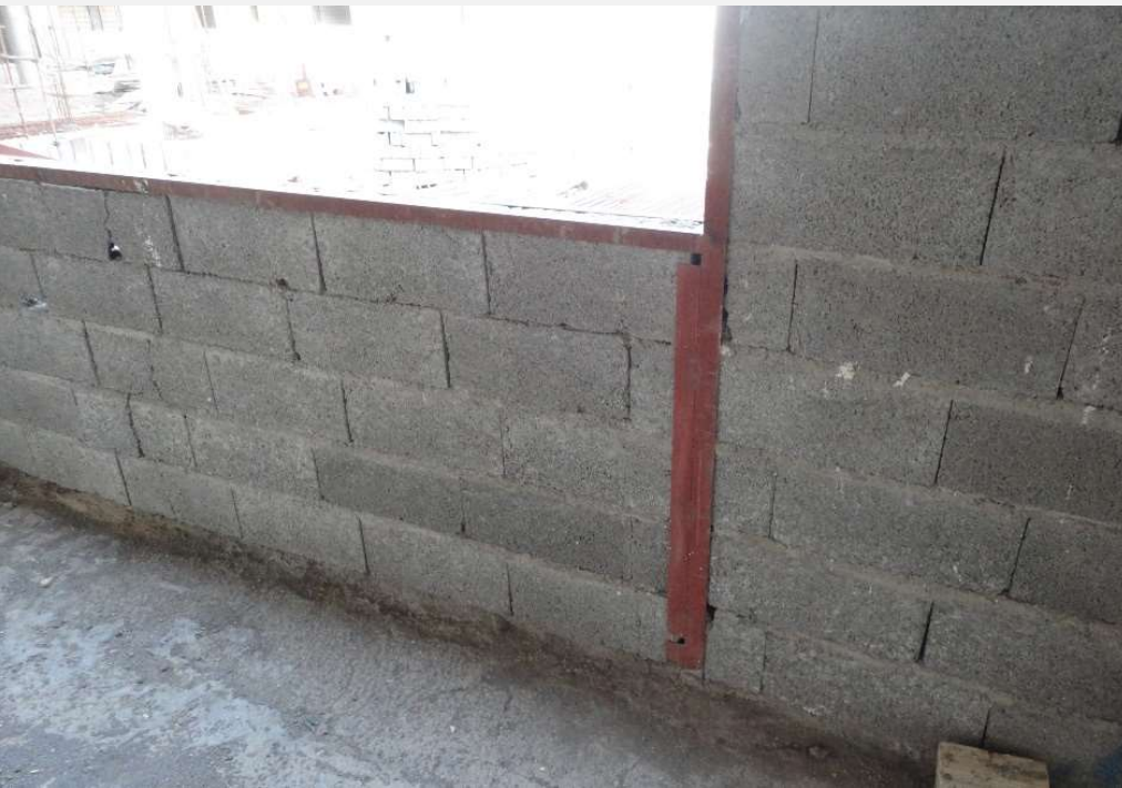
اجرای صحیح مهار دیوار در جهت خارج صفحه در پایین پنجره
