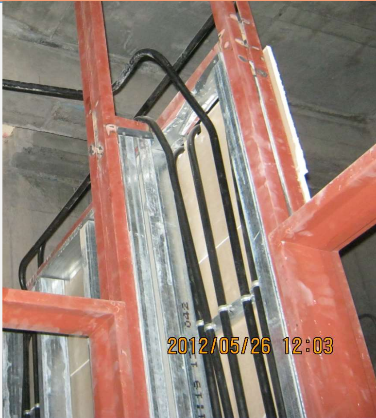
عدم برش مقطع مهار جهت عبور لوله های سمینار اجزای غیر سازه ای تاسیساتی
