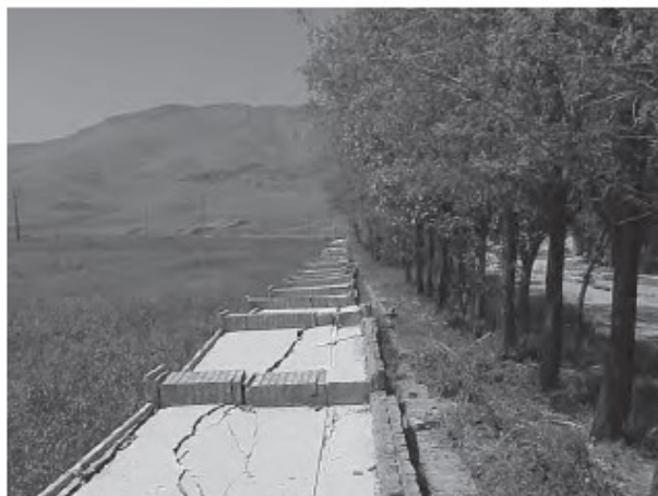
نمونه‌ای از خسارات وارد شده به دیوارها در زلزله ۱۳۸۵ لرستان
