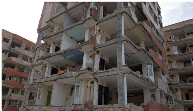
تخریب دیوارهای محیطی به دلیل عدم اجرای وال پست و نمای سنگین آجری
