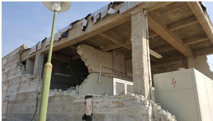
تخریب دیوار محیطی در اتاق برق
