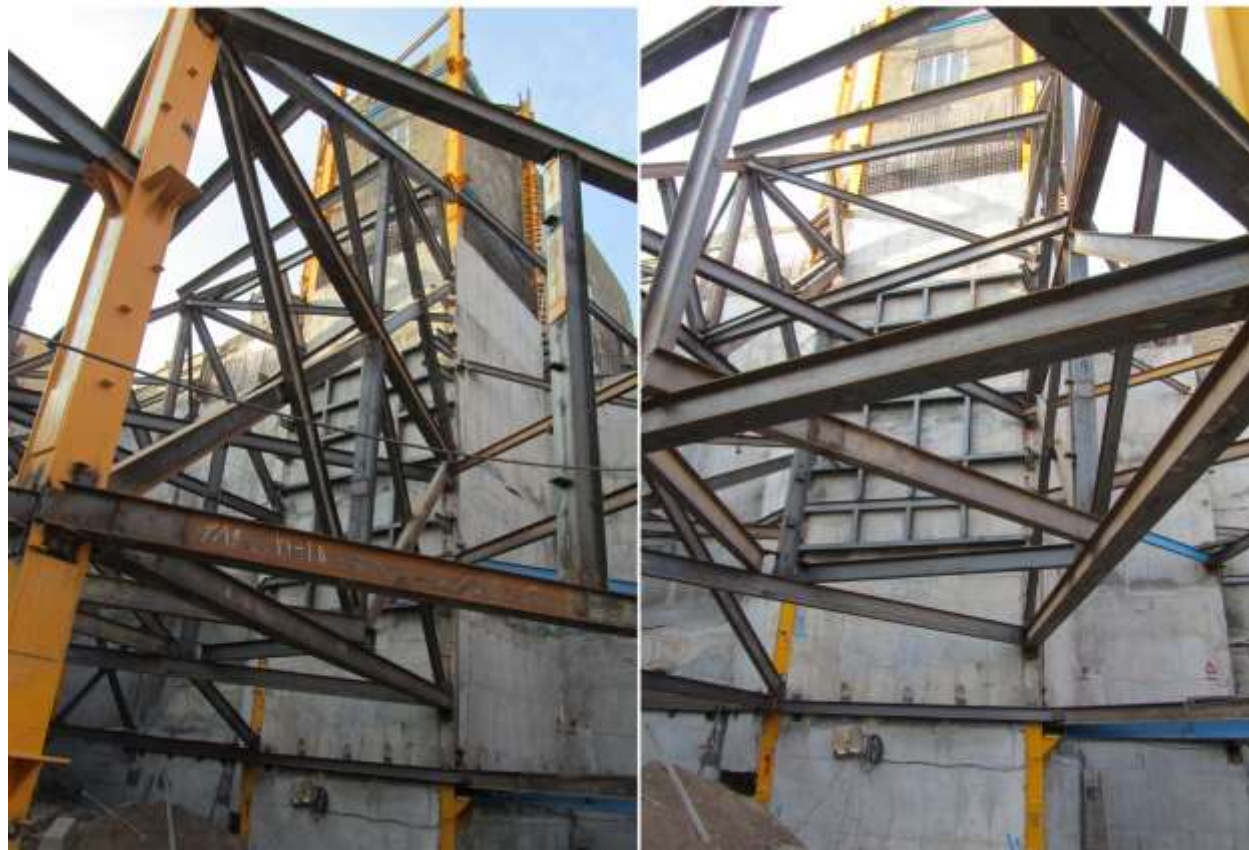
شکل ۹-۵. مقاوم سازی‌های انجام شده برای متوقف نمودن تغییر شکل پیش‌رونده
