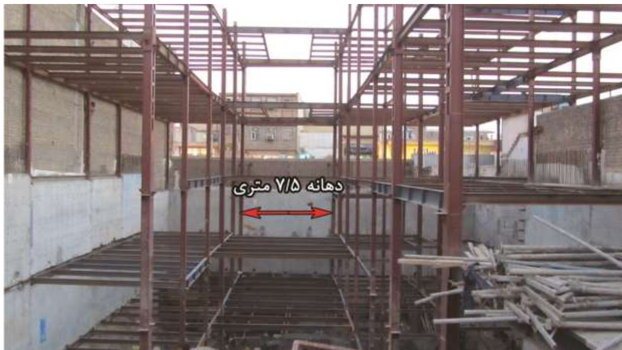
شکل ۳-۱۰. دهانه ۷/۵ متری در ضلع جنوبی گود پروژه میدان پلیس قم، پایدارسازی شده به روش ساخت از بالا ناقص [۱۸]
