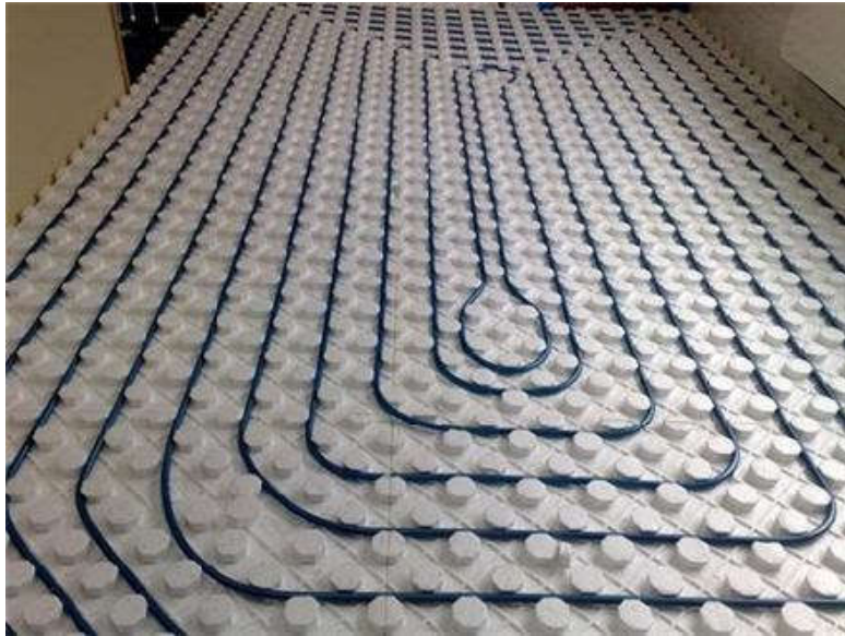
شکل ۵-۵۰: تصویری از زمان اجرای لوله‌های گرمایش از کف [50].
