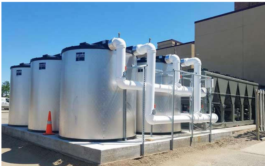
شکل ۶-۱: نمایی از کاربرد بانک یخ در کنار چیلر تراکمی [60].
