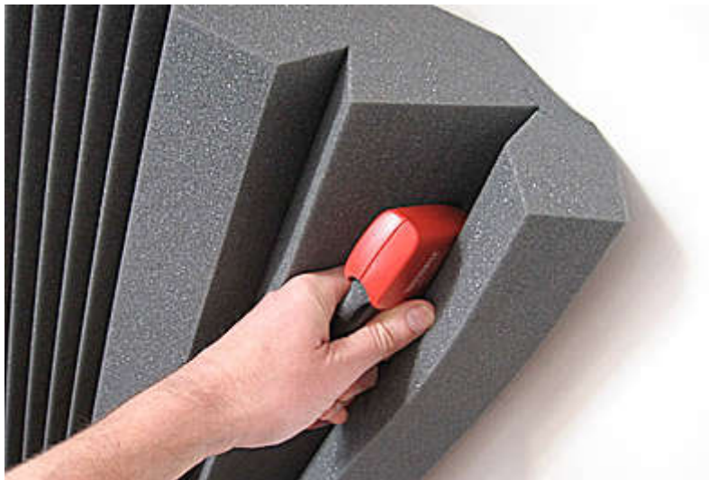
شکل ۶-۳ استفاده از منگنه برای نصب فوم آکوستیک [۱۴]
