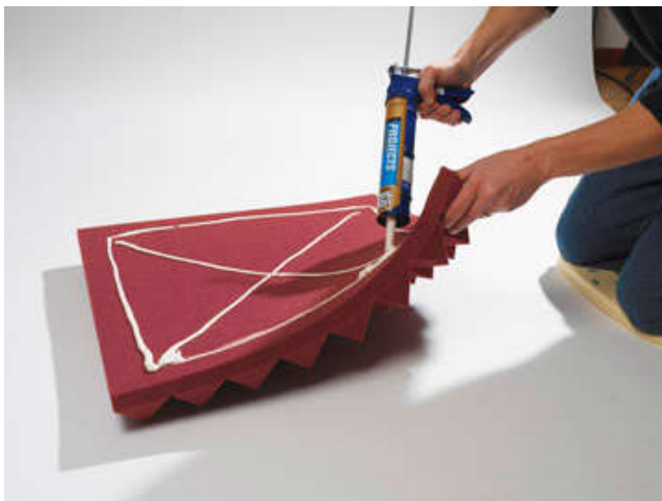
شکل ۴-۶ استفاده از چسب برای نصب فوم آکوستیک [۱۵]
